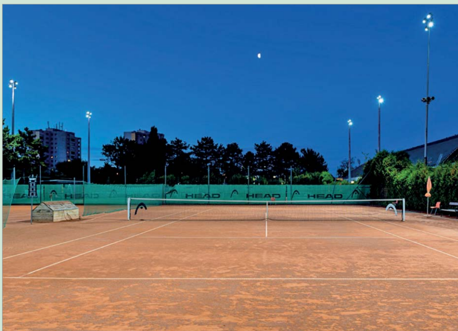
Umweltgerechte LED-Beleuchtung im LZ Südstadt
